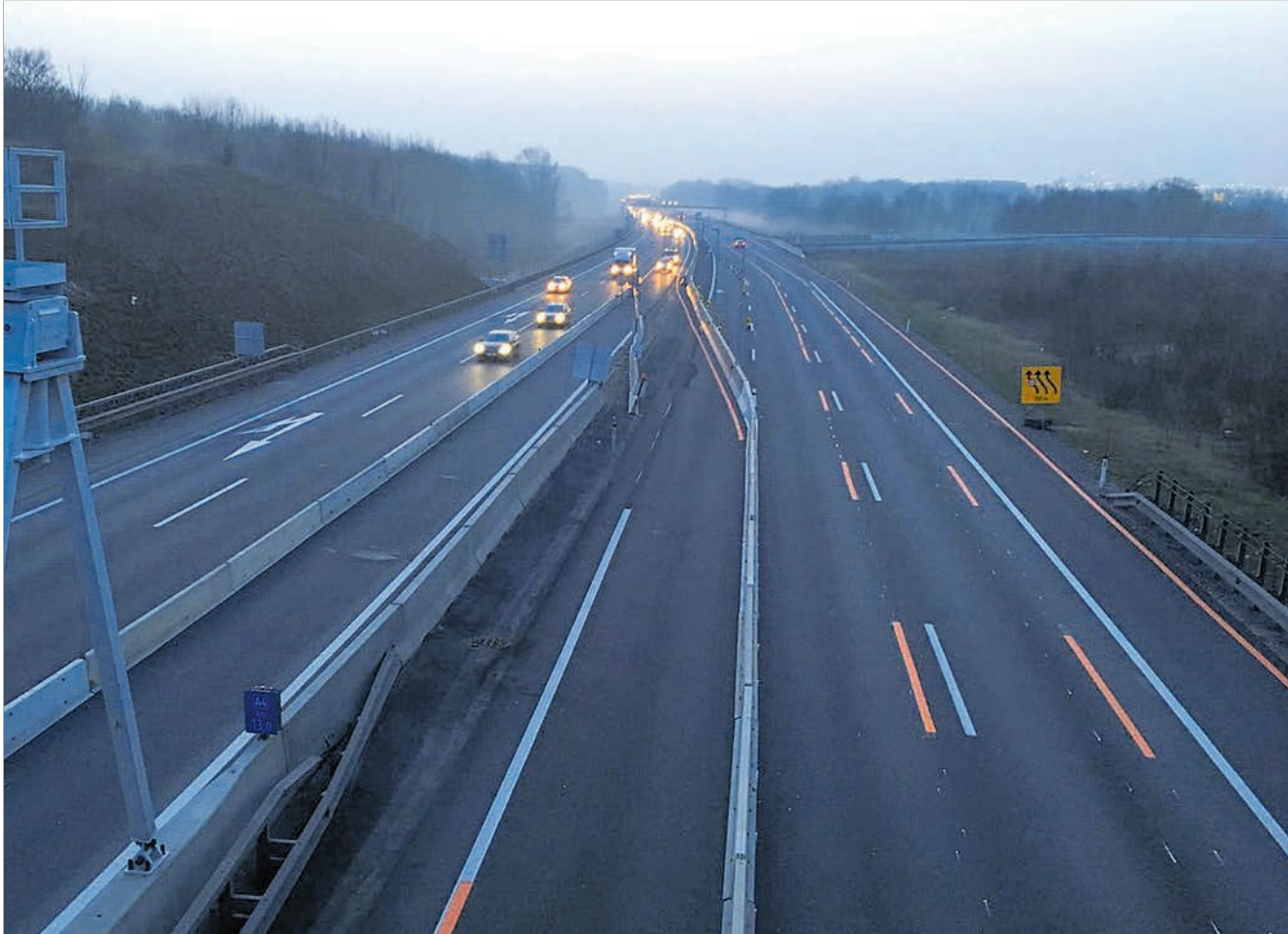
Seit 20. März wird die Autobahn A4 saniert.
