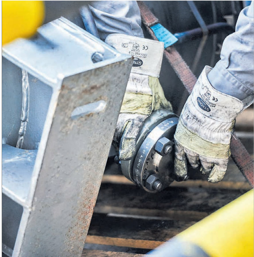
Detailreiche Vorbereitungsarbeiten ermöglichen den reibungslosen Ablauf des etwa zwei Monate dauernden Turnarounds.
